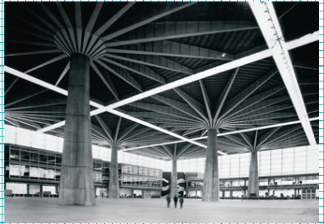
Fig. 2 Palazzo del Lavoro - Pier Luigi Nervi
